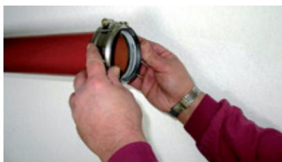
1. Соединитель Rapid DN 80 надеть на трубу или фасонную часть DN 80.
