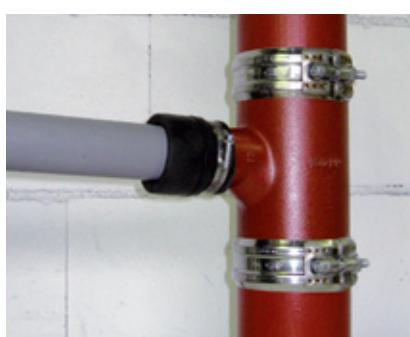
4. Изображение пластиковой трубы приведено только для примера. При помощи соединителя EK-Düker-Fix к трубе SML можно подключать канализационные трубы с указанными диаметрами, из любого материала. Внимание: следует учитывать данные в таблице диаметров для подключения.
