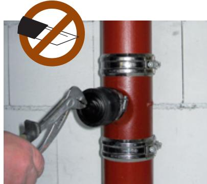
2. При помощи клещей захватить и аккуратно оторвать заглушку так, чтобы образовалось отверстие.
