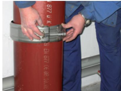
6. Винт с шайбой установить в натяжное устройство.
