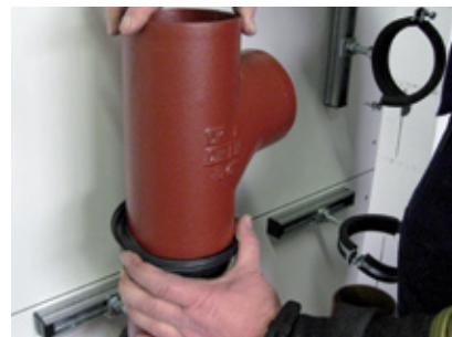
3. Поместить следующую трубу или фасонную часть прямо на внутренний буртик уплотнения и завернуть часть уплотнения.
