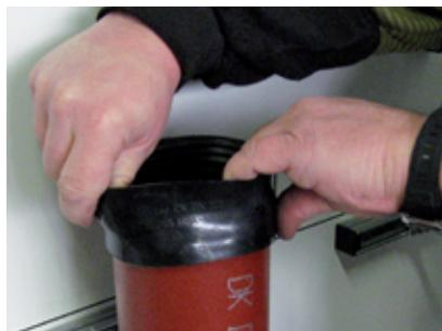
1. Сначала надеть резиновое уплотнение на нижнее окончание трубы таким образом, чтобы дистанционное кольцо резинового уплотнения легко на торец трубы.
