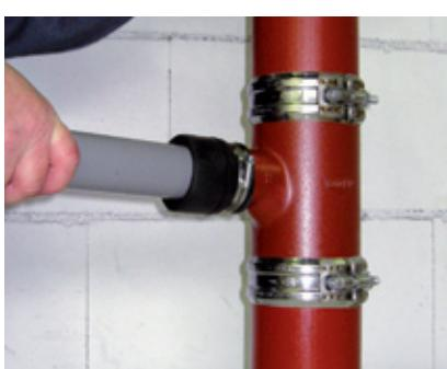
3. Отметить на соединяемой трубе глубину входа. Покрыть антиадгезионным средством и вставить трубу в отверстие.
