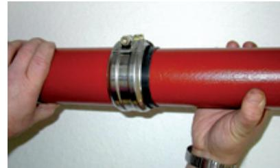
3. Трубу или фасонную часть SML DN 70 с переходником вставить в соединитель Rapid DN 80.
