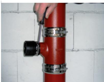
1. Соединитель Düker EK-Fix из ЭПДМ; хомут с червячной резьбой из хромированной стали 1.4016. Используется для соединения труб SML с трубами из других материалов.
