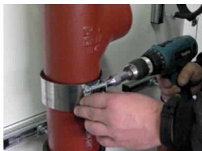
5. Наживить оба винта и равномерно затянуть. Обе планки хомута должны оставаться параллельными, для предотвращения перекоса хомута.
